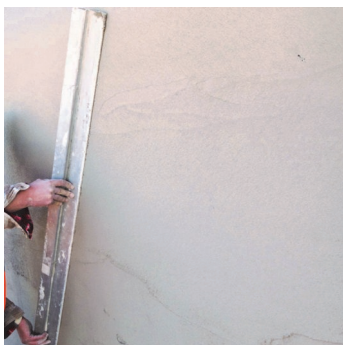
Obr.2 Urovnání povrchu "h-latí".
