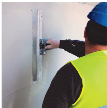
Obr.3 Urovnání povrchu fasádní špachtlí.
