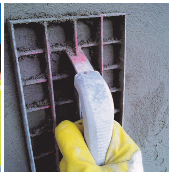
Obr.4 Následující den strhnout povrch škrabákem.
