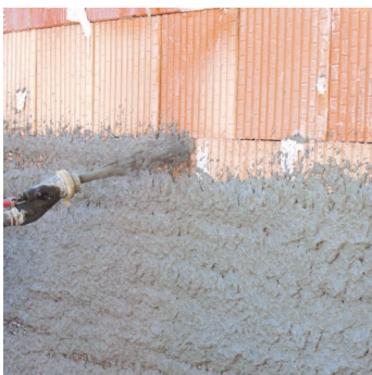
Obr.1 Nástřik omítky pomocí omítačky.
