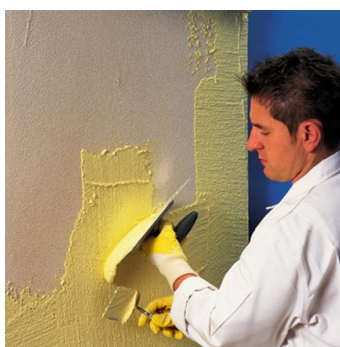
Obr.3 Nanesení omítky nerezovým hladítkem.
