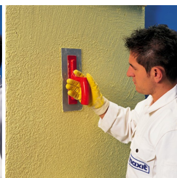
Obr.4 Strukturování povrchu plastovým hladítkem.
